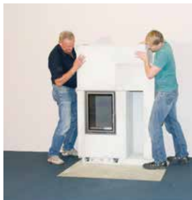
Verkleidungselemente Stück für Stück zusammensetzen und verkleben
