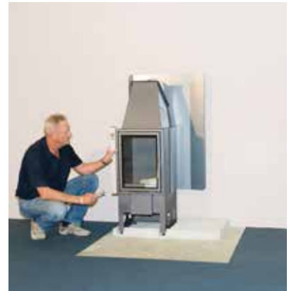
Kamineinsatz mit Wasserwaage einrichten
