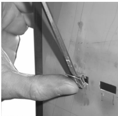
Abbildung 5: Einstecken des Snap-On-Clip
