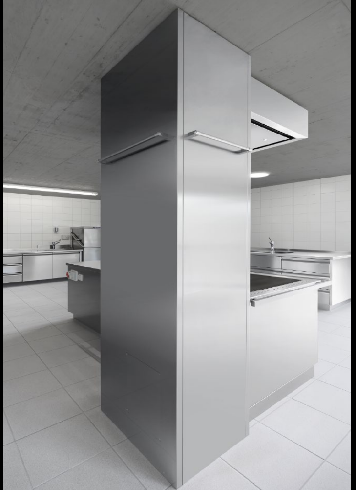
Säule komplett in Edelstahl verkleidet
