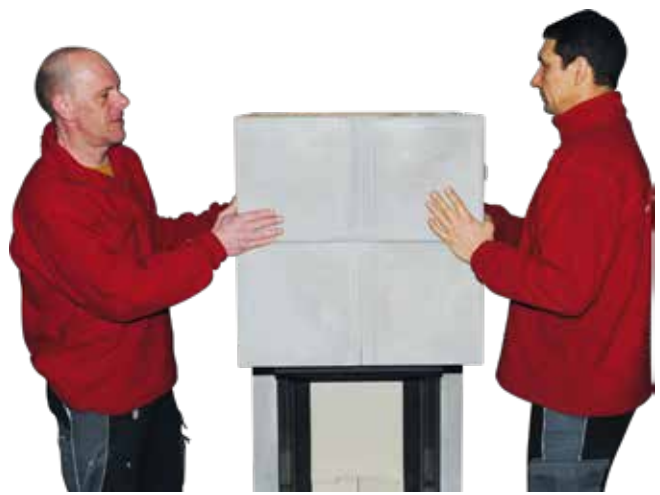
16. Oberteil ohne zu verkleben auf die Seitenteile setzen.
