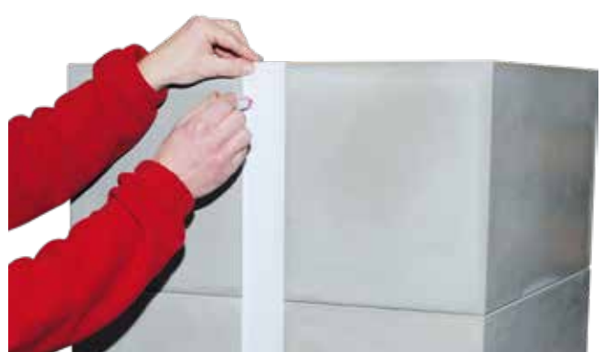
19. Position der Haltebolzen für „obere“ Frontblende (621mm) mit Schablone markieren und mit 6 mm-Bohrer (ohne Schlag) entsprechend bohren.
