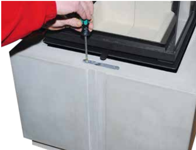
15. Verbindungslasche unten mit Senkkopfschraube M6x20 mm montieren.
