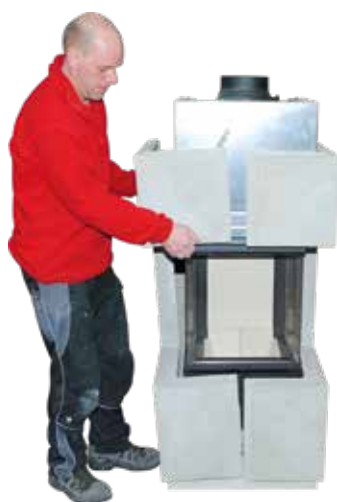
13. Seitenteile rechts und links ohne zu verkleben auf die Bodenplatte setzen (Kamineinsatz evtl. nachjustieren).
