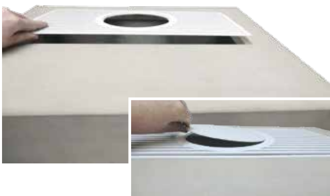
18. Deckengitter und Einlegedeckel in die vorgesehene Öffnung einsetzen.
