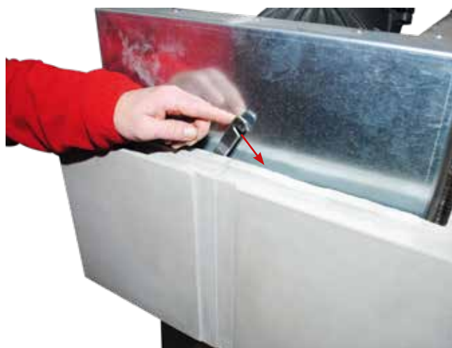
14. Haltelasche oben hinter den Schraubenkopf am rechten Seitenteil drücken.
