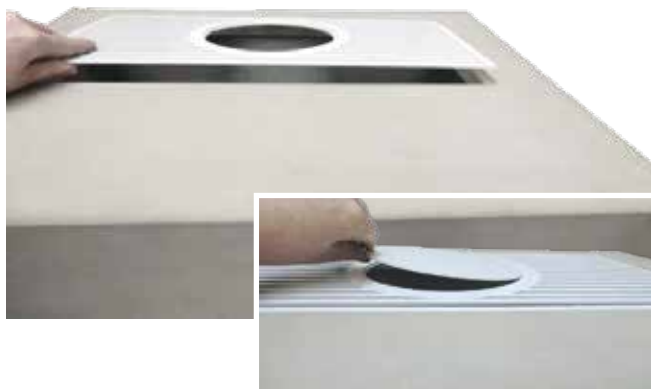
12. Deckengitter und Einlegedeckel in die vorgesehene Öffnung einsetzen.
