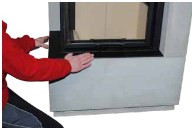
13. Bankplatte auf das Unterteil setzen und unter die Traverse schieben. Bankplatte ausrichten.
