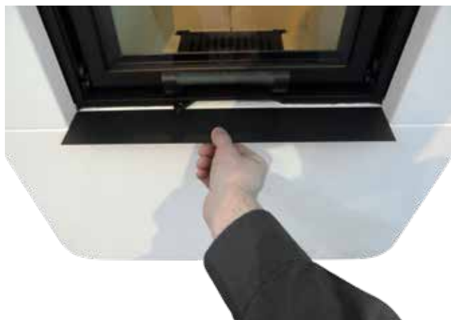
19. Schutzabdeckung unter den Frontrahmen schieben und evtl. punktuell fixieren ( nur bei Ausführung ohne Bank ).
