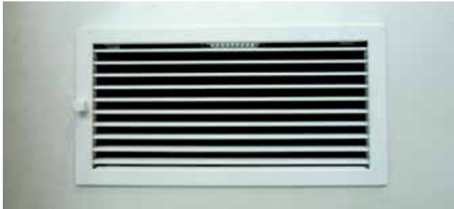
Abb.:1 Beispiel für ein geöffnetes verstellbares Gitter (nicht in jeder Anlage verbaut)
